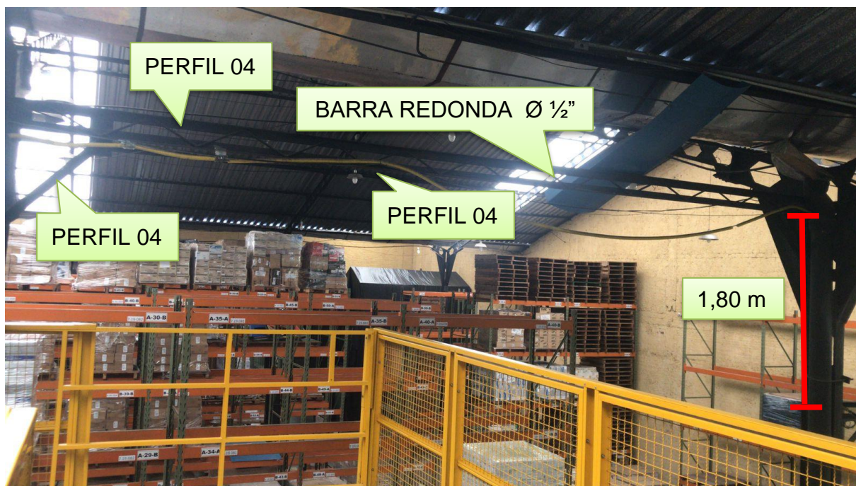
FIGURA 23 - TRAVAMENTO DESLOCADO ENTRE P45 E P46
