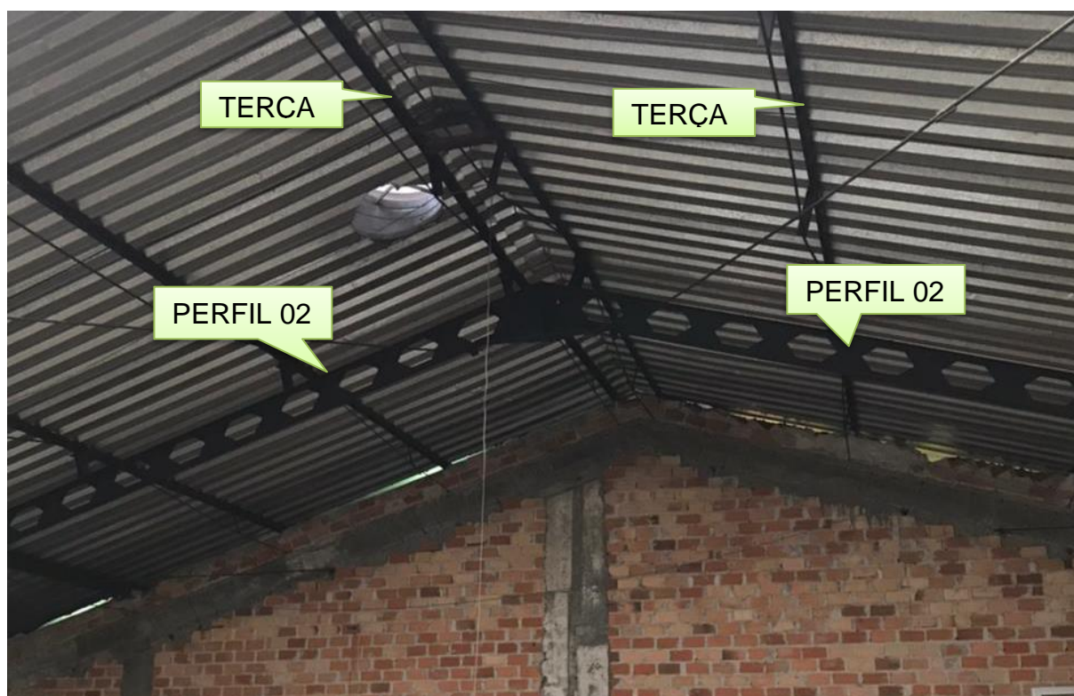
FIGURA 36 - LIGAÇÃO ENTRE AS TESOURAS
