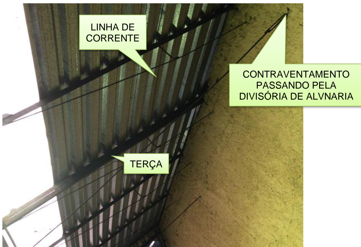
FIGURA 44 - CONTRAVENTAMENTO ENTRE A DIVISÓRIA
