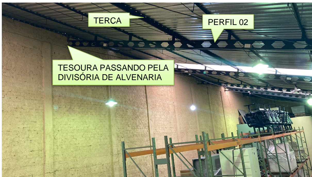
FIGURA 35 - TESOURA ENTRE DIVISÓRIA DE ALVENARIA
