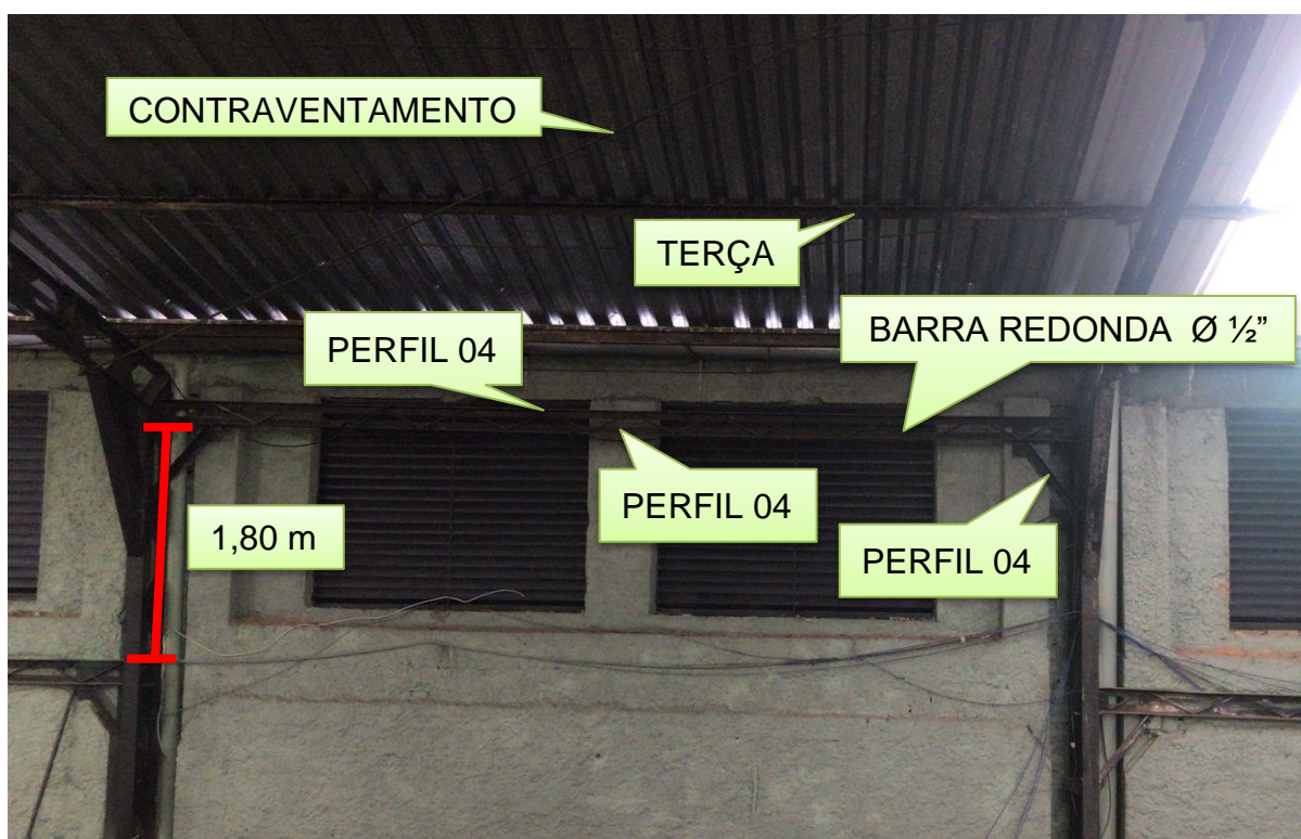
FIGURA 24 – TRAVAMENTO DESLOCADO ENTRE P53 E P54
