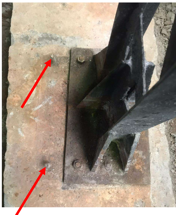
FIGURA 58 - AUSÊNCIA DE PARAFUSO NO P19
